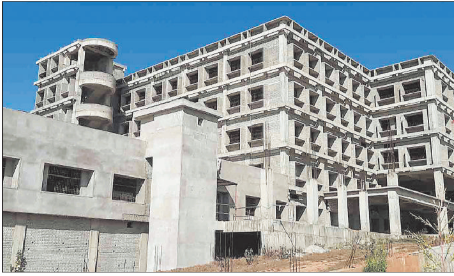
निर्माणाधीन मेडिकल कॉलेज अस्पताल।
